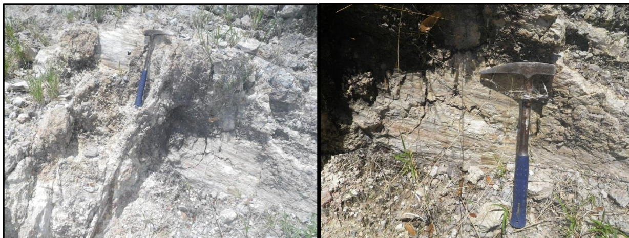
Foto 3. Brechas por falla en el área de estudio
